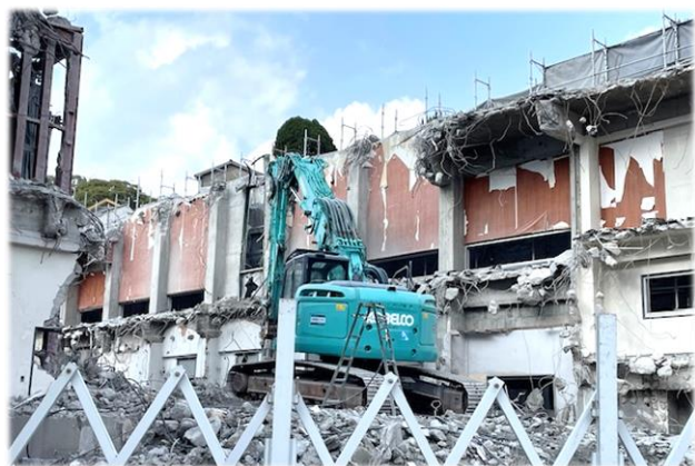
* 教会の聖堂の天井が解体されていく
