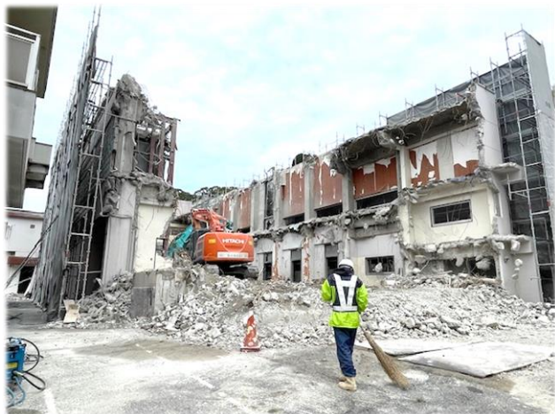
* 更に解体は進み・・・
